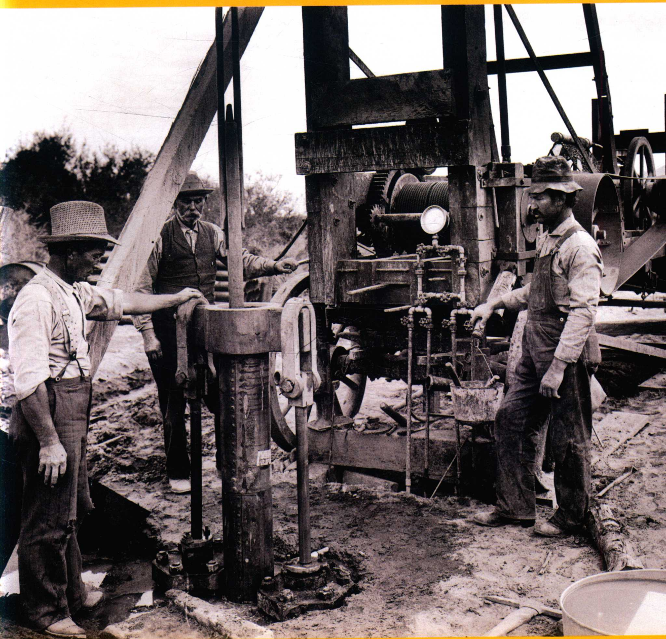
20 世纪初，人们正在用一台钻孔机钻一口水井。
