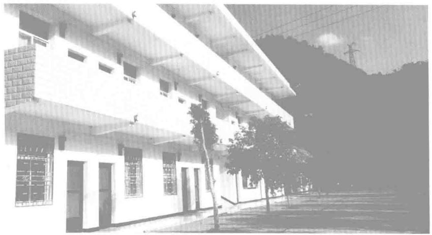
淇南水电站生活区
