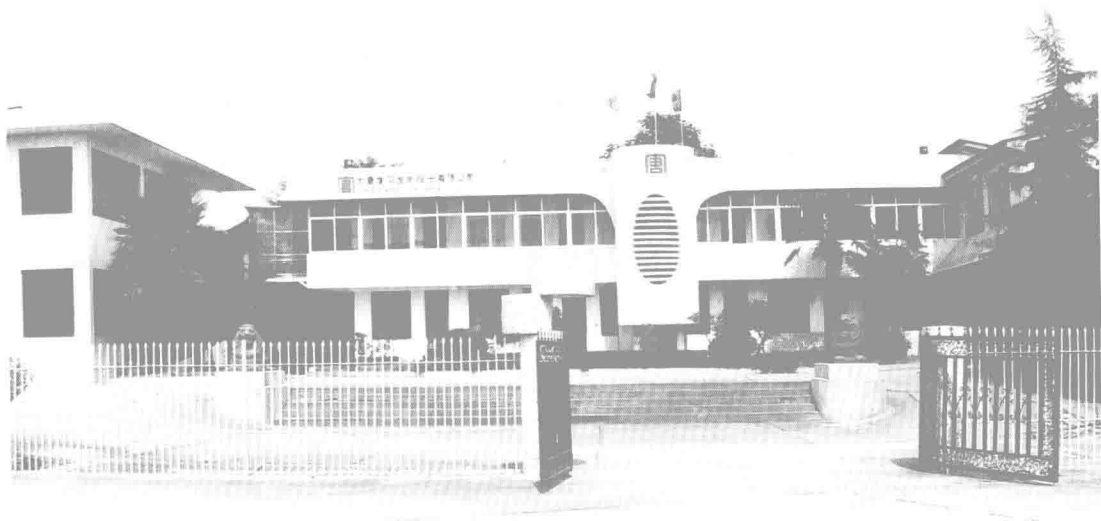
白渔潭水电站办公楼
