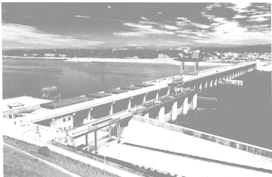
大源渡航电枢纽全景
