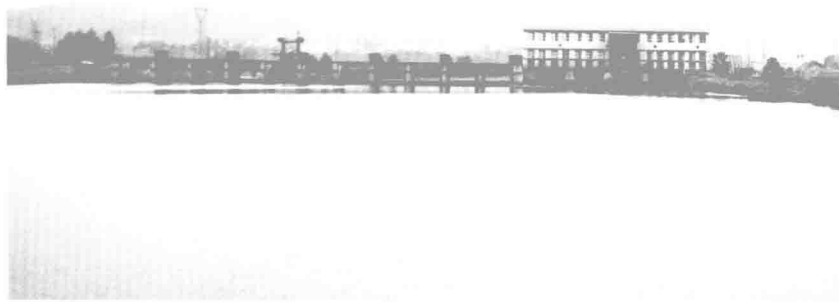
鲤鱼江水电站
