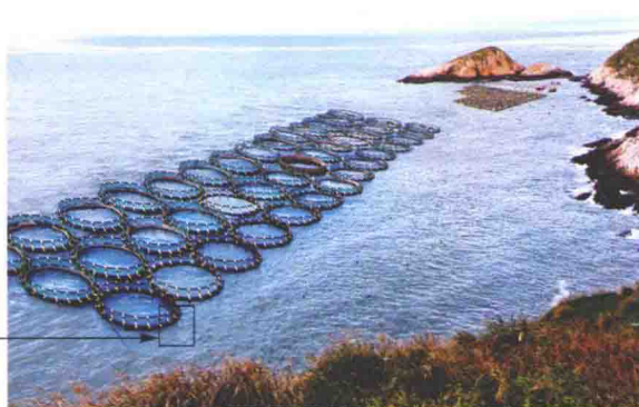
▲ 高密度聚乙烯(HDPE)圆形全浮式网箱
