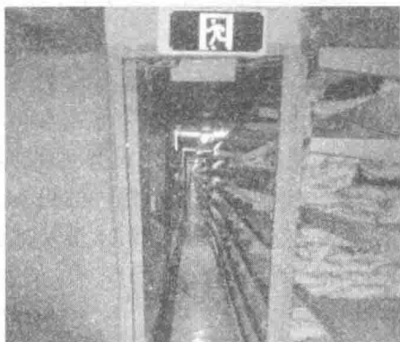
图 1.1-13 管廊内防火门及防火封堵
