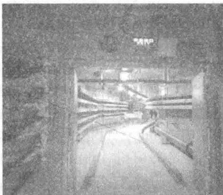
图 1.1-13 管廊内防火门及防火封堵
