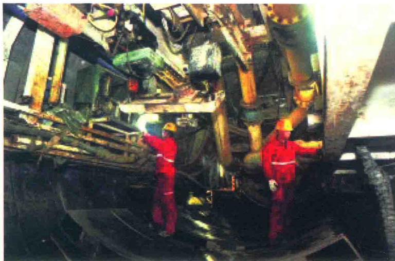
图 0-5 技术人员对盾构机进行维护保养
