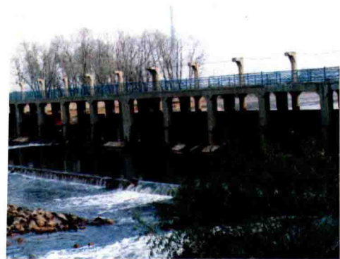
南沙河东台拦河闸
