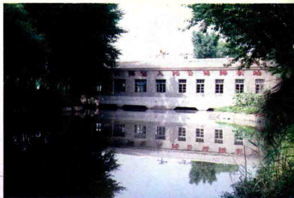
大阳气排水站
