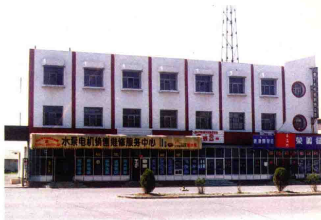
新禹地下水开发利用公司、钻井队办公楼
