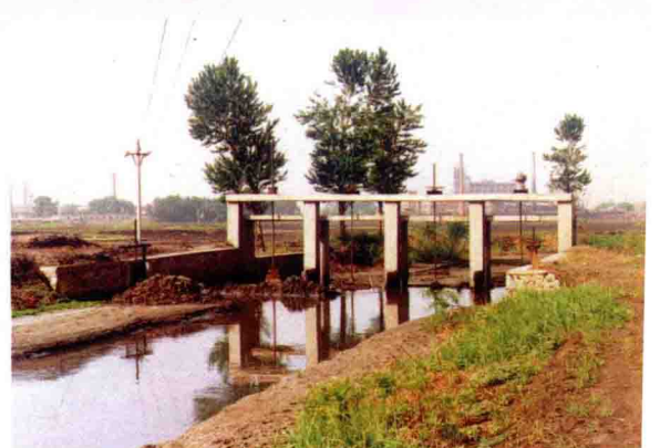
鞍钢污水李三台闸
