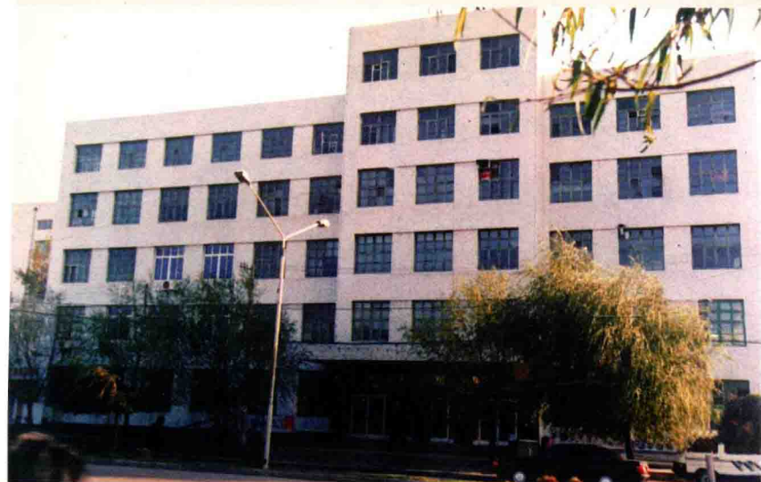
区水利局办公大楼
