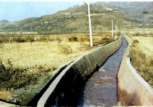
唐家房镇西果子园村开发的千亩水田防渗干渠
