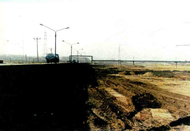
南沙河太平村段新筑的河堤及堤旁公路
