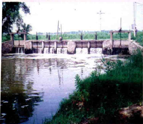
运粮河大阳气拦河闸
