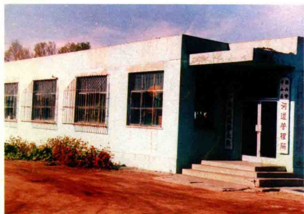
区河道管理所、水政监察大队办公室
