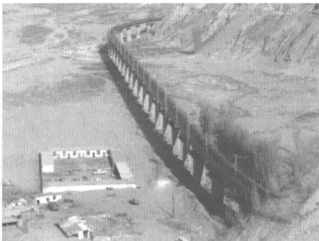
图 1-2 沙漠地区的桥梁结构体系（混凝土+钢结构）
