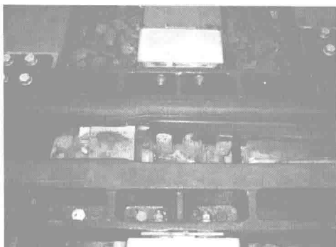
图 1.6 心轨水平藏尖结构
