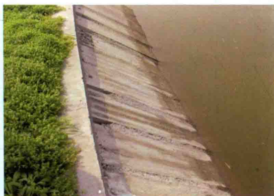
水泥预制板护坡
