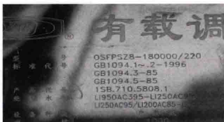
图 1-2 变压器铭牌（局部）
