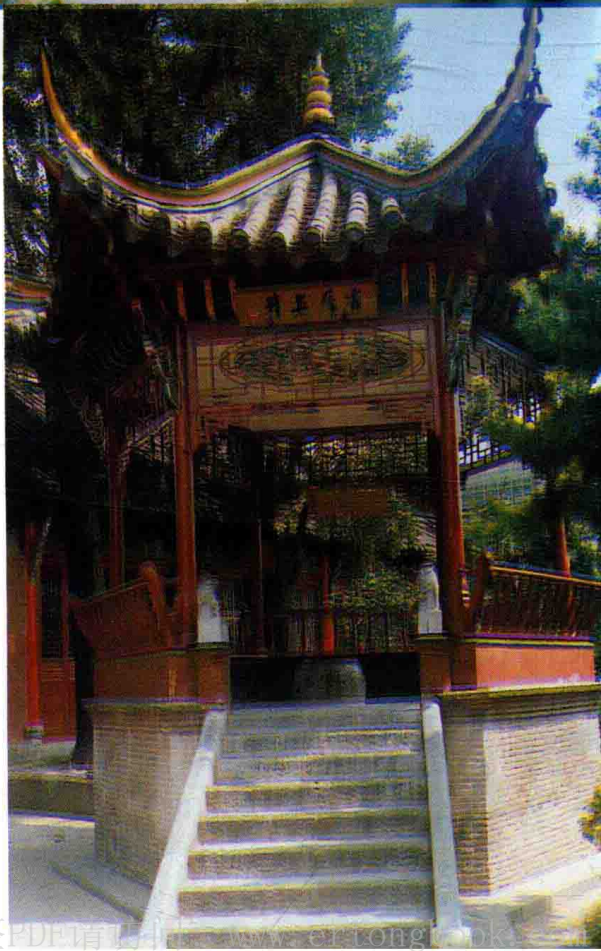
建于古教弩台上的屋上井
