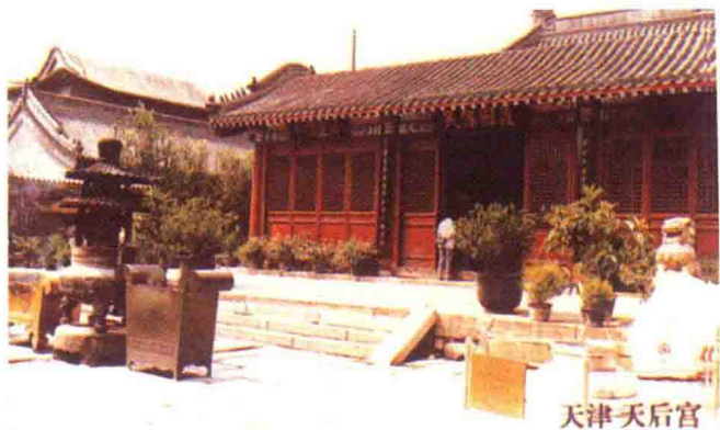
图1 重新修复后的天津天后宫大殿外景
