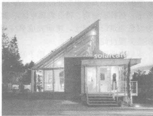
图 1.2 主动式太阳房——日本太阳能咖啡屋
