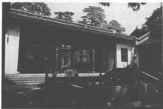
礼圣门(始建于宋,近代维修)
