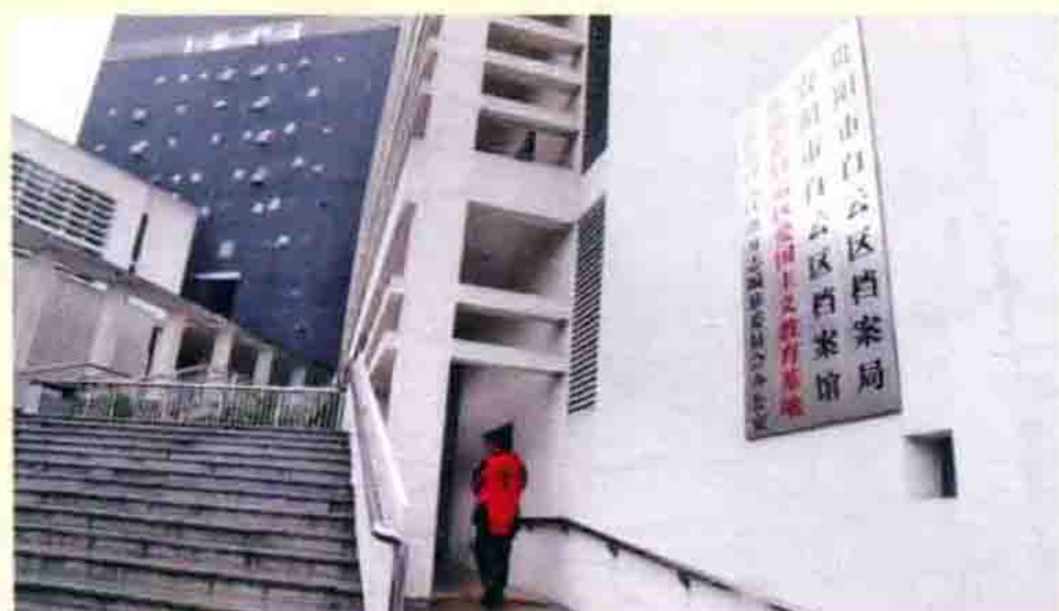
白云区档案局（馆）、地方志办综合行政办公楼
