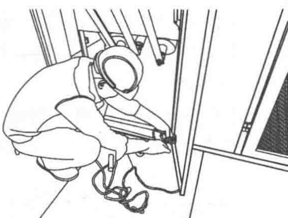
(d) 装设接地线
