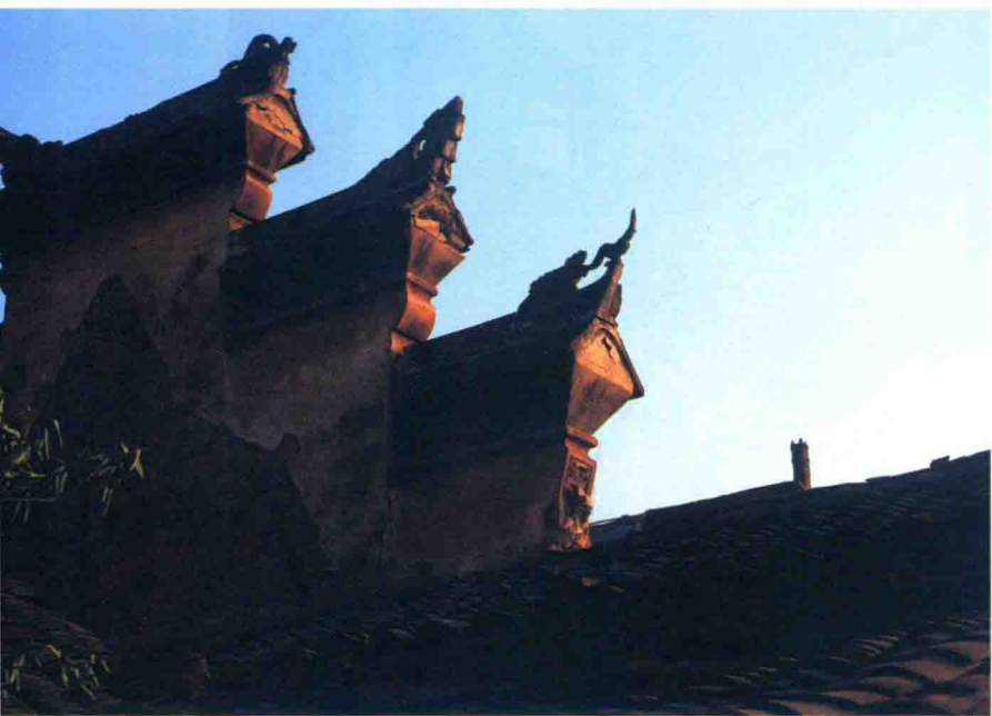
封火山墙（四川，铁佛镇）
