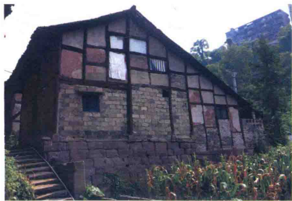
屋顶与穿斗（四川，沿口镇）
