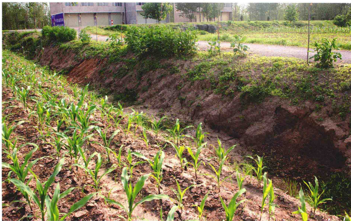
1. 四铺镇百陈村北堤堤坝（镜向西南）
