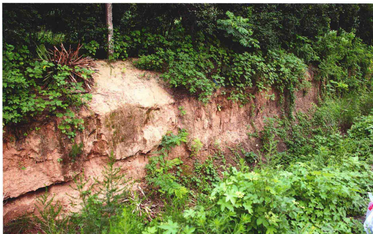
2. 铁佛镇二道口村苗圃北堤堤坝外侧护坡（镜向东）
