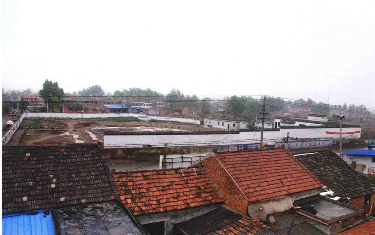
1. 发掘区域外砌筑砖墙与居民区隔开
