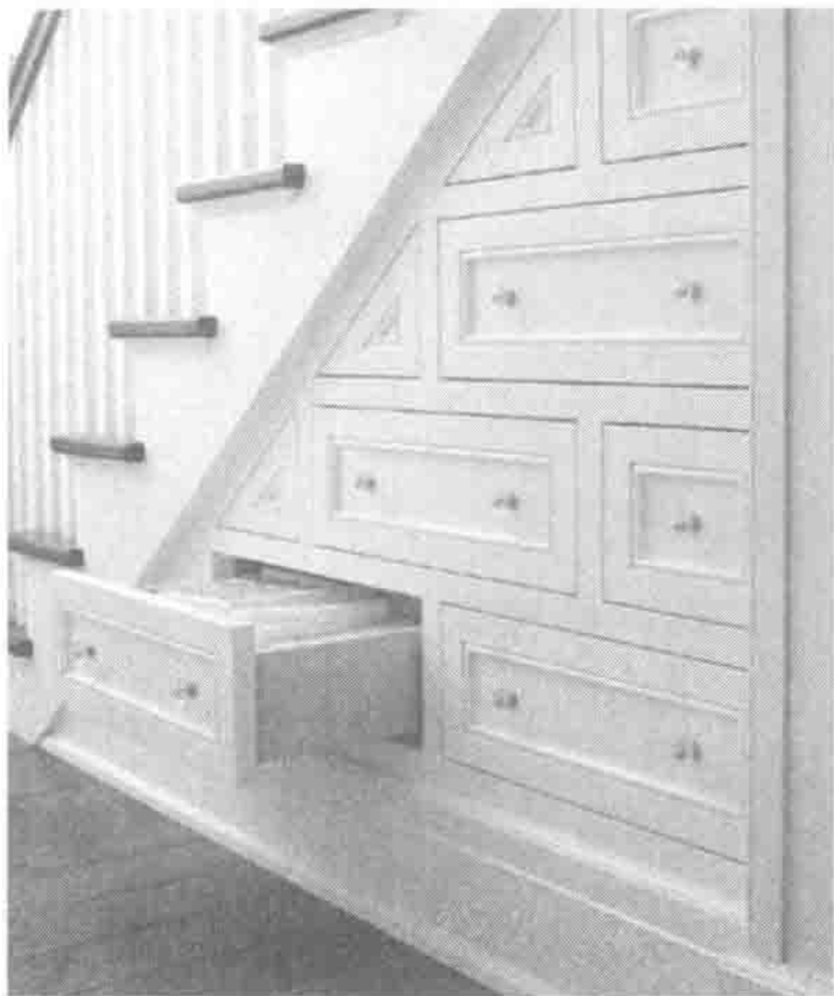
图 1-2-6 将楼梯下方改造成书柜使其具备储物功能
