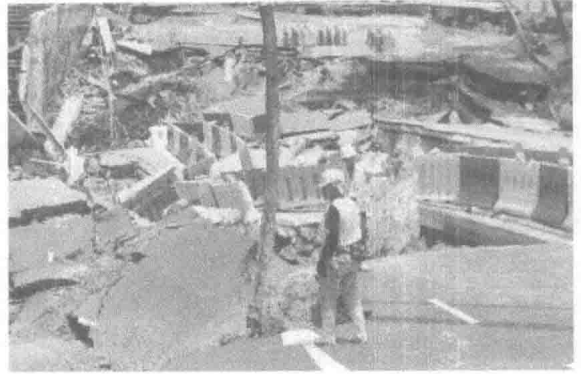
图 1-10 新加坡尼诺大道坍塌事故
