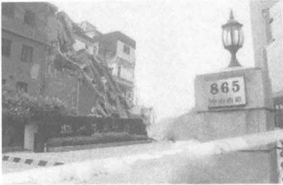
图 1-9 上海轨道交通 4 号线重大工程事故
