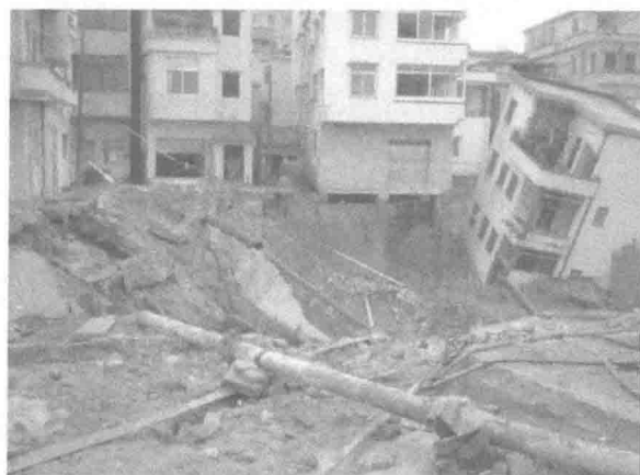
图 1-8 广州地铁 3 号线沥滘站塌方
