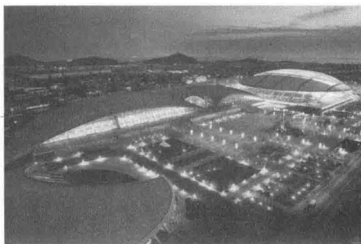
图 1-23 南通体育场——开合式屋盖
