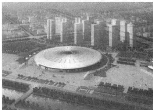
图 1-27 中国(太原)煤炭交易中心主体工程
