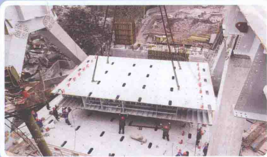
重庆东水门长江大桥最重的一块桥面板(约70t)吊装
