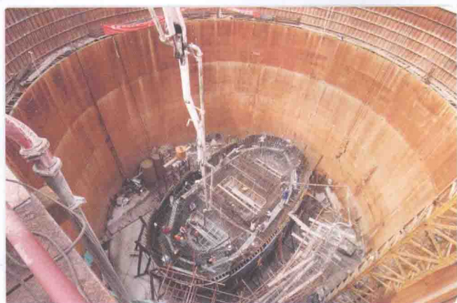
千厮门嘉陵江大桥主塔首节段浇筑
