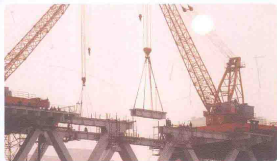
重庆东水门长江大桥最后一根合龙杆件吊装
