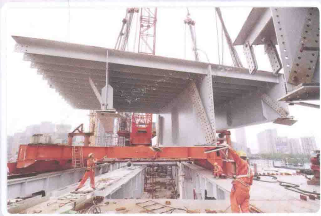
千厮门嘉陵江大桥桥面板吊装
