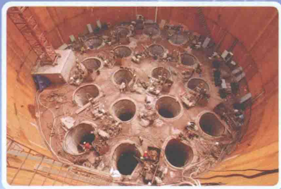
千厮门嘉陵江大桥钢围堰内挖孔桩施工
