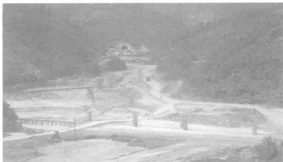
图 1 路堑超高边坡工点地形
