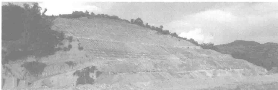
图 2 工点开挖揭示地层情况
