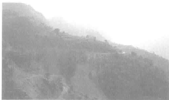
图 1 路堑高边坡工点地形
