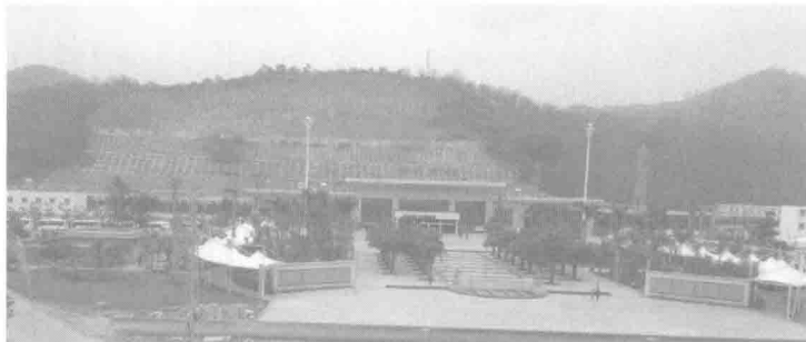
图7 边坡工程施工完毕的远景效果
