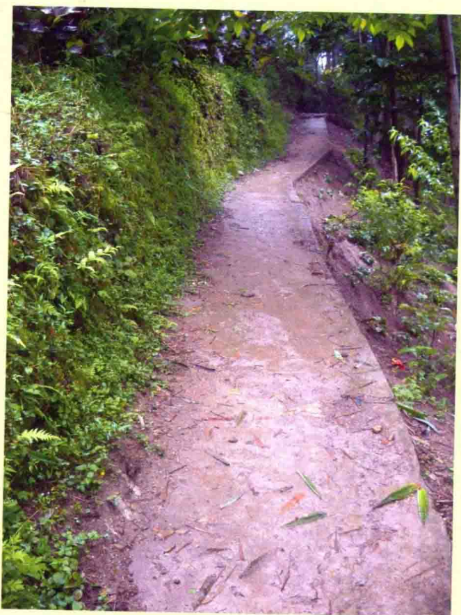
LW 村水泥路
