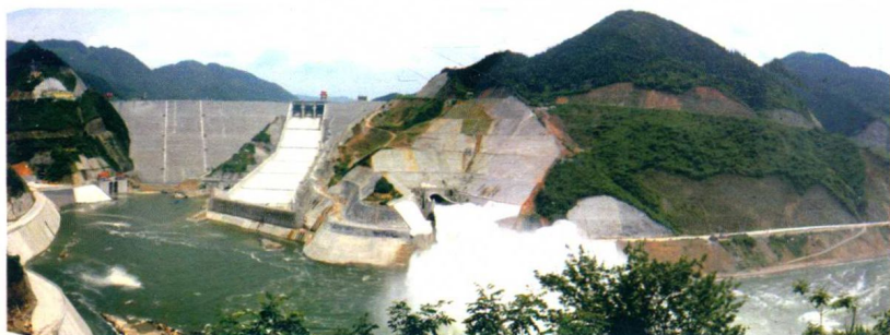
三板溪水电站首次泄洪
