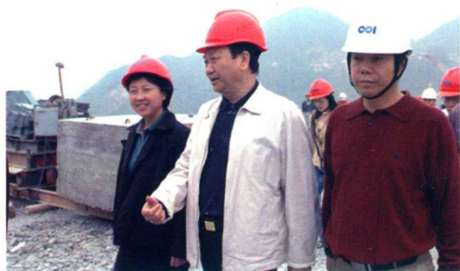
中共贵州省委常委、省委 统战部长龙超云(左一)到三板 溪水电站施工现场视察
