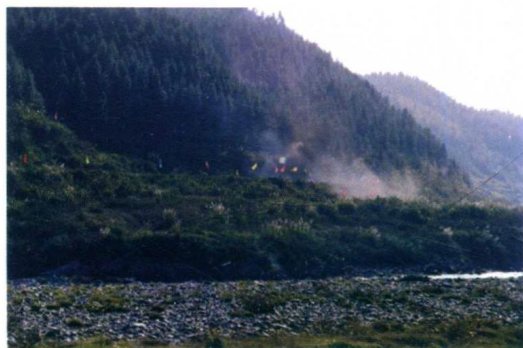
2001年11月15日三板溪水电站进场公路在锦屏八洋村打响了工程建设的第一炮
