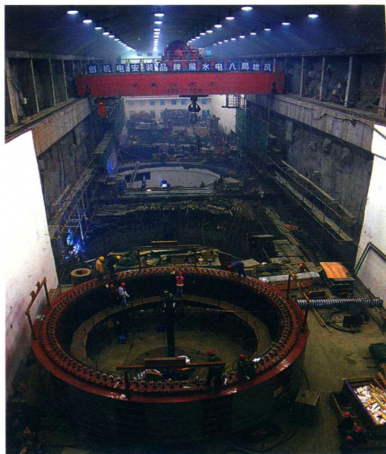
第一台机组安装的火热情景
