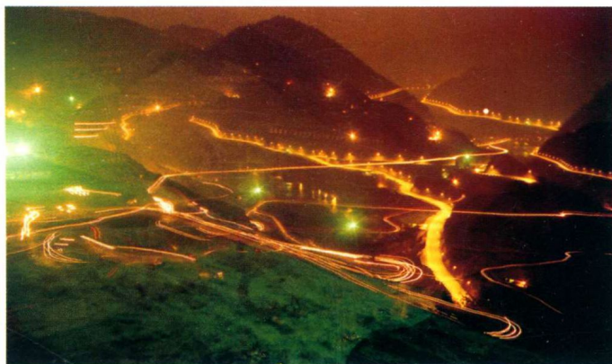
三板溪水电工程施工夜景
