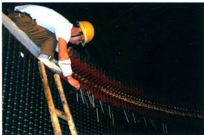
技术人员在安装机组部件
