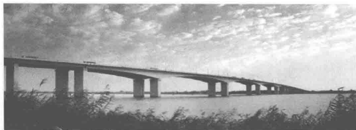
图 1.2 南京长江第二大桥北汉桥
