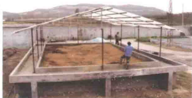
彩图 20 处理病死猪尸体的生物发酵池
