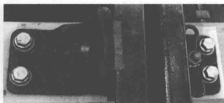
图 1.7 整铸护轨垫板
