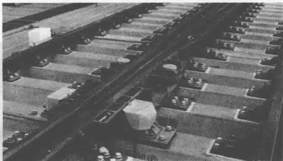
图 1.5 可动心轨辙叉高锰钢整铸翼轨
