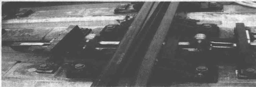
图 1.13 18号道岔翼轨和轨底牵引
