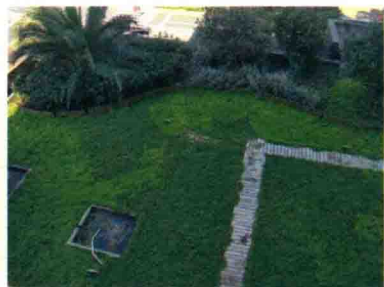
图 1-12 半集约式屋顶花园（上海市闵行区某证券公司营业部）
