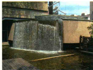
图 1-3 屋顶亲水平台
