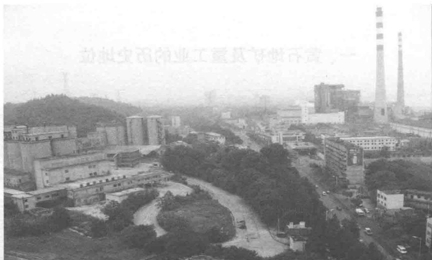
华新水泥厂(原大冶水泥厂)与黄石电厂(原大冶电厂)
