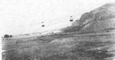
利华煤矿高空索道
