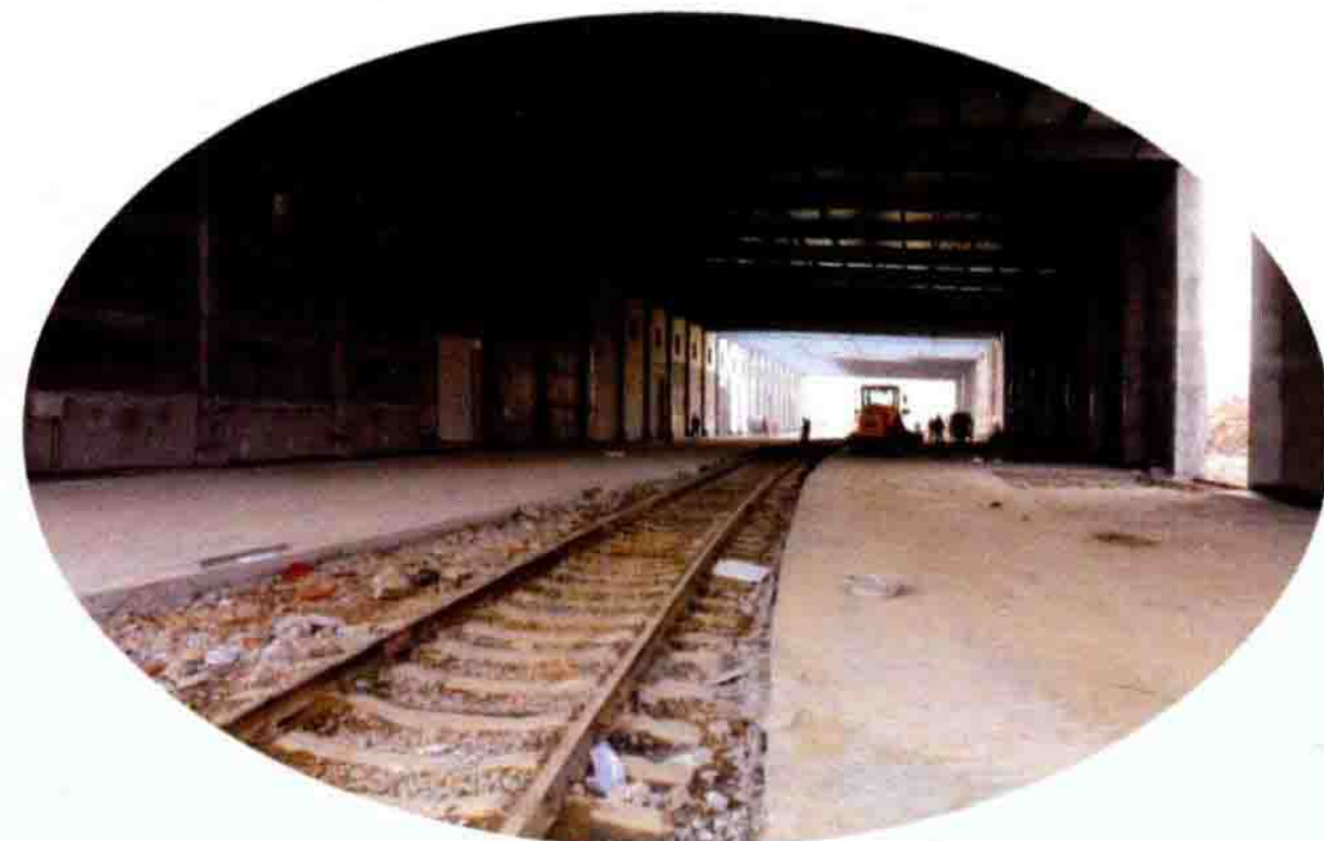
京粮集团辉南基地铁路专用线
