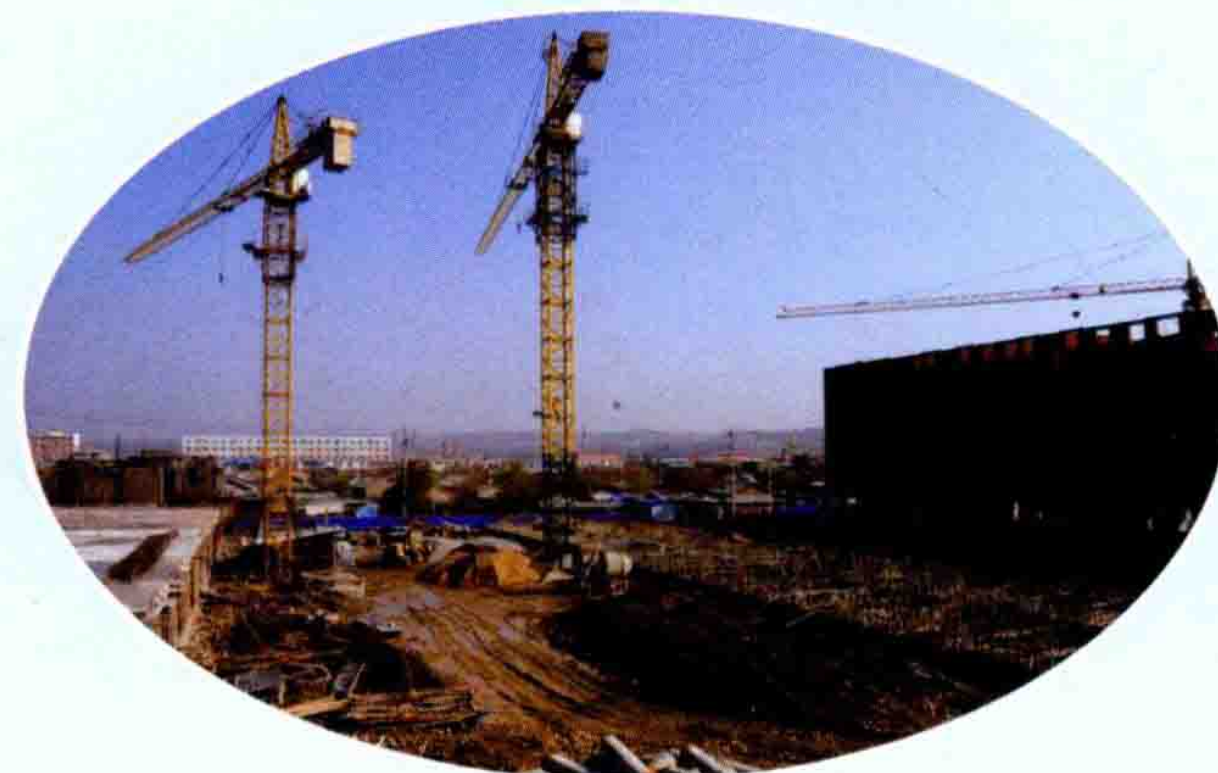
建设中的和乐家苑小区
