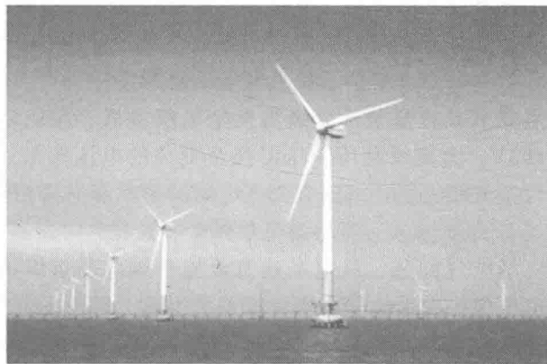
图 1-3 东海大桥风电场
