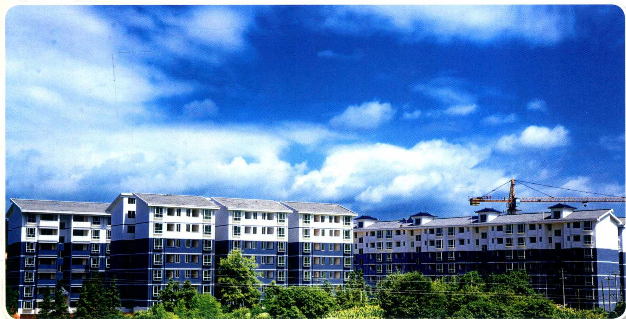
敦寨新建的生态移民安置楼房
