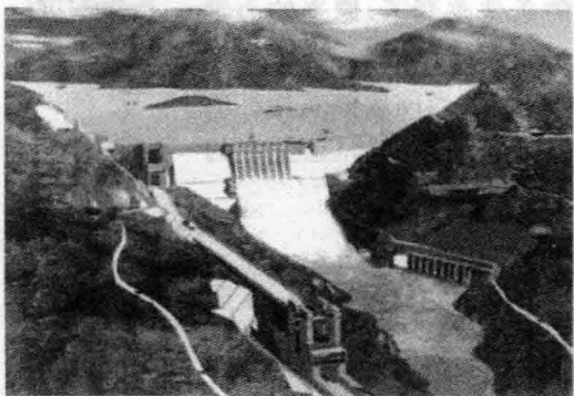
图 0-4 大型水利工程
