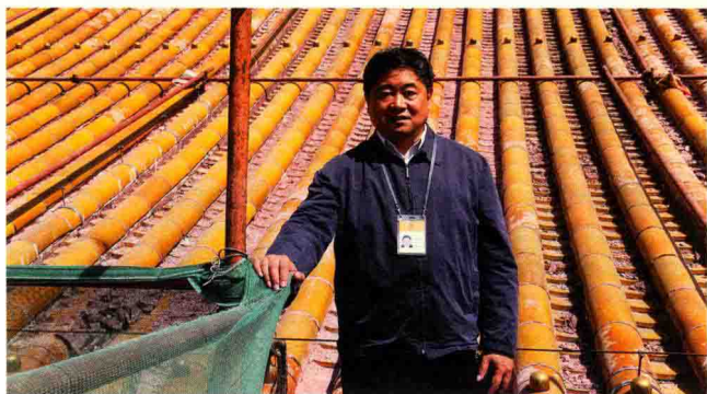
2013年5月1日，作者在故宫博物院太和殿维修现场 周高亮摄
