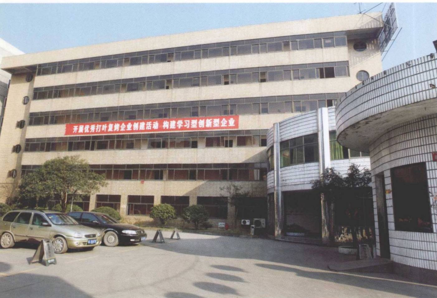
▲ 天泰公司办公大楼
