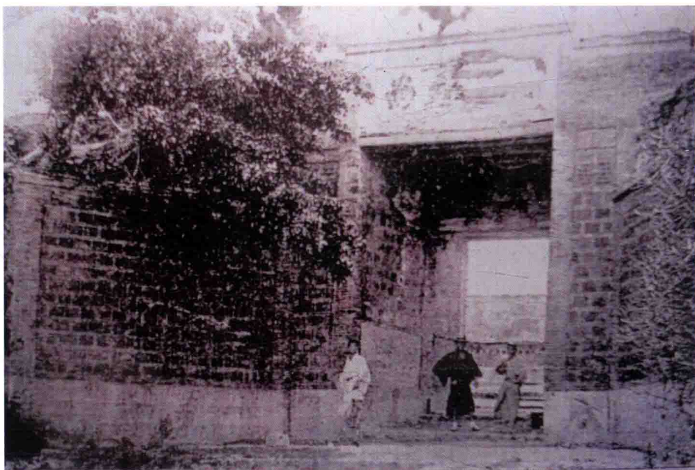
图1-6 1895年6月，高雄旗后炮台入口
