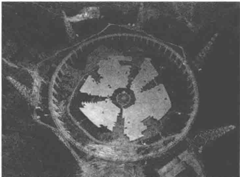
图 1-12 馈源支承系统施工首次升舱
