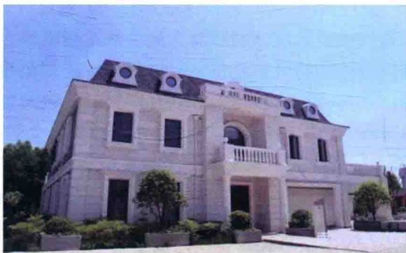
图 1-2 3D 打印技术建造的别墅
