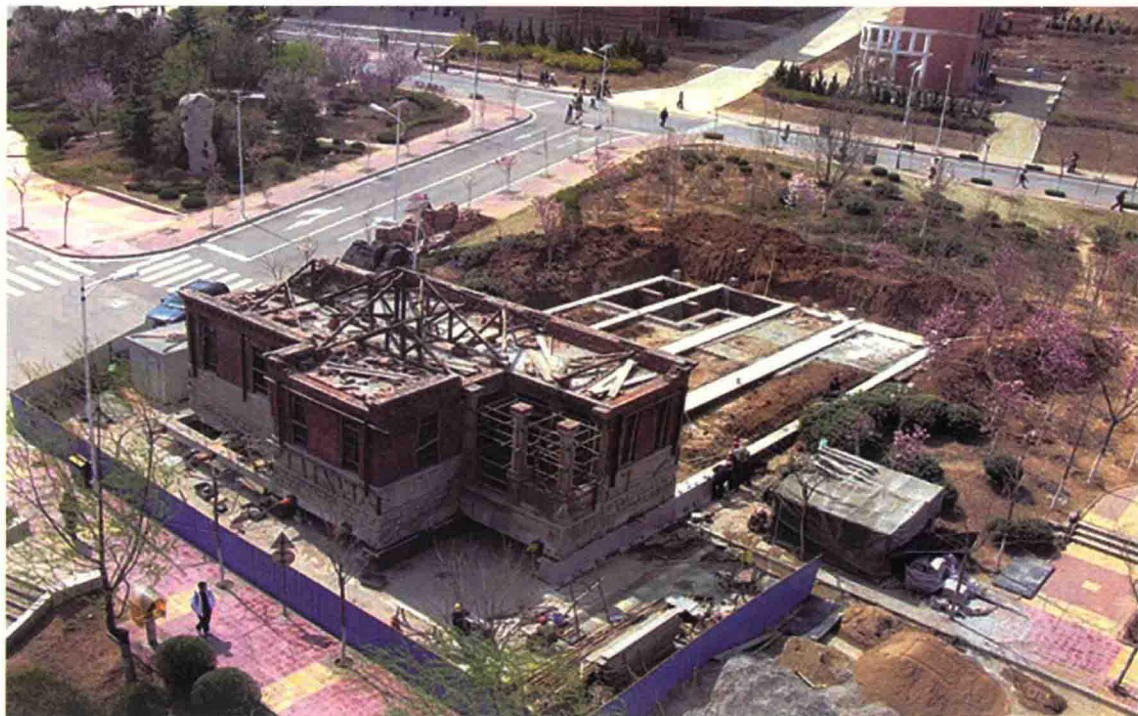
采用传统平移方式将老别墅平移至指定位置
