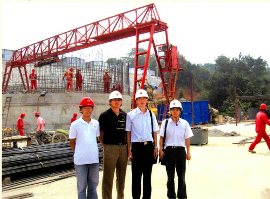
西气东输二线长江穿越工程九江盾构工地留影（2008）
