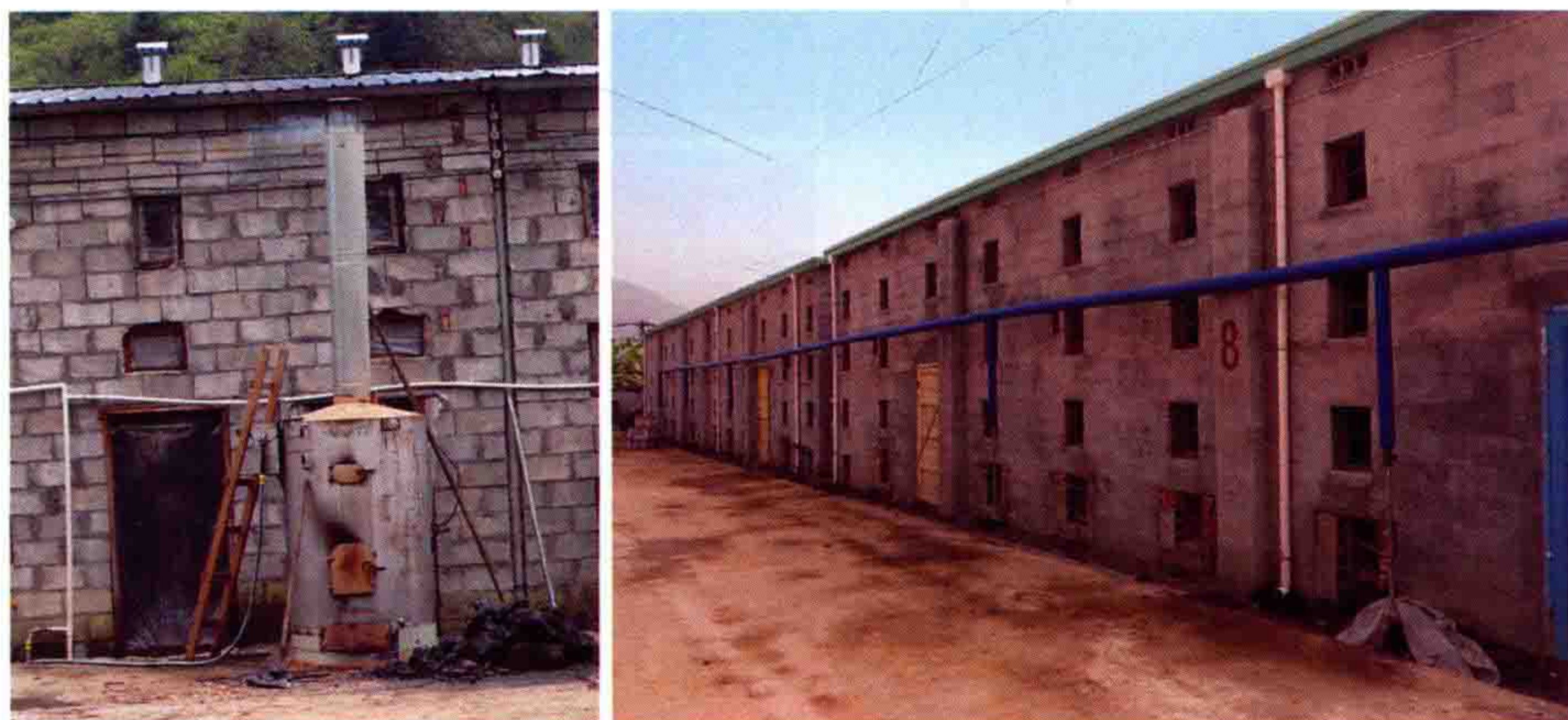
小型锅炉产生蒸气通入菇房
