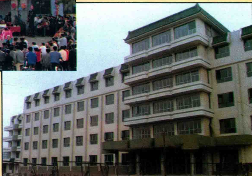
在校友和师生员工赞助下建造的“教育交流中心”即将竣工
