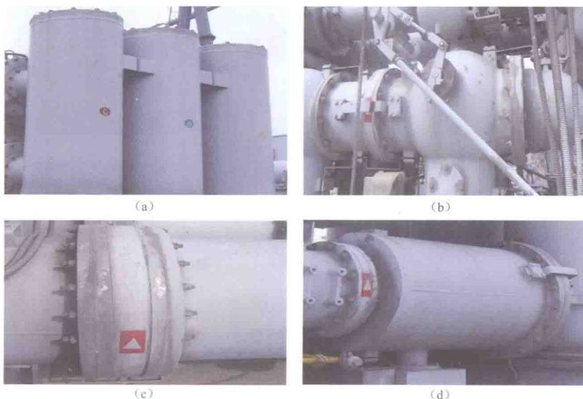
图 1-3 红外热成像的重点检测部位（一）
