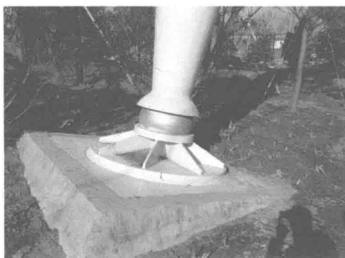
a) 结构实拍
