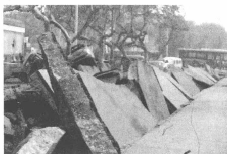
(a) 青岛输油管道原油泄漏爆炸
