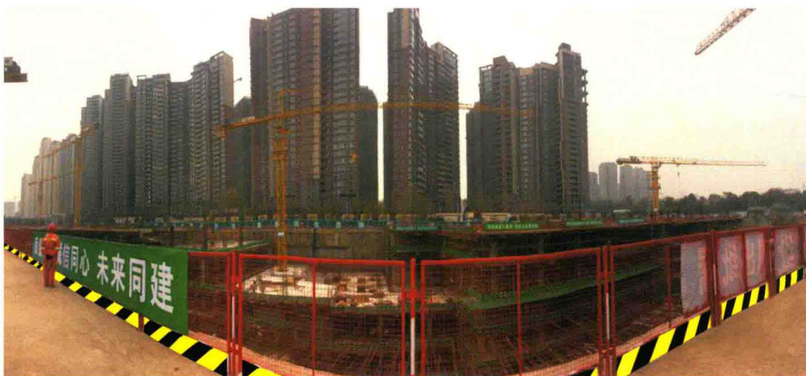
基坑临边防护安装效果图
