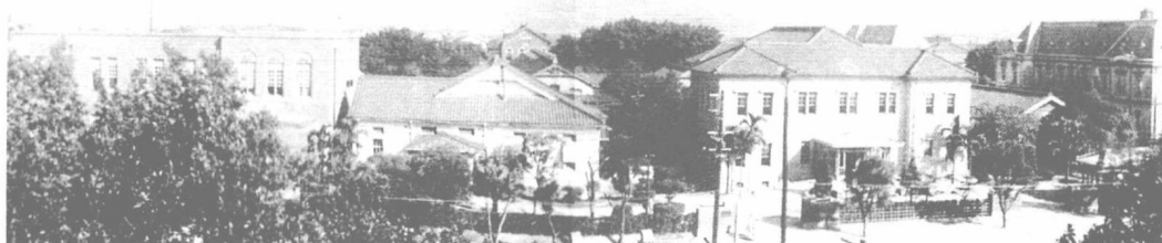
圖三 1942年，由舊台大醫院病房屋頂遠眺校區，日赤病院舊本館屋頂已翻修，左方為新本館。
