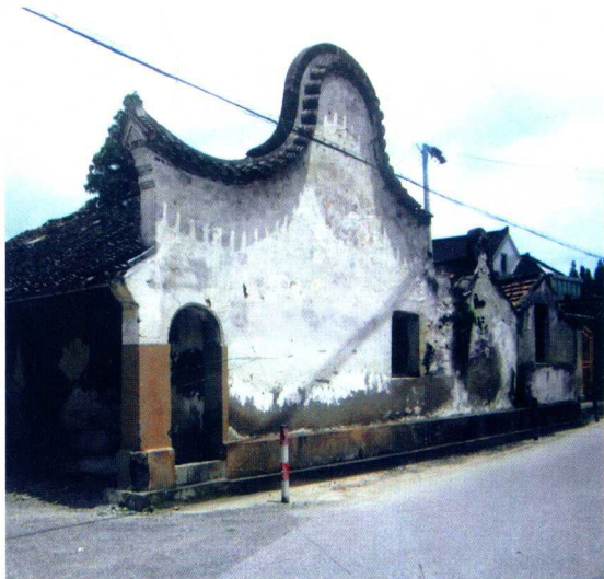
· 横沙岛丰乐镇风火墙
