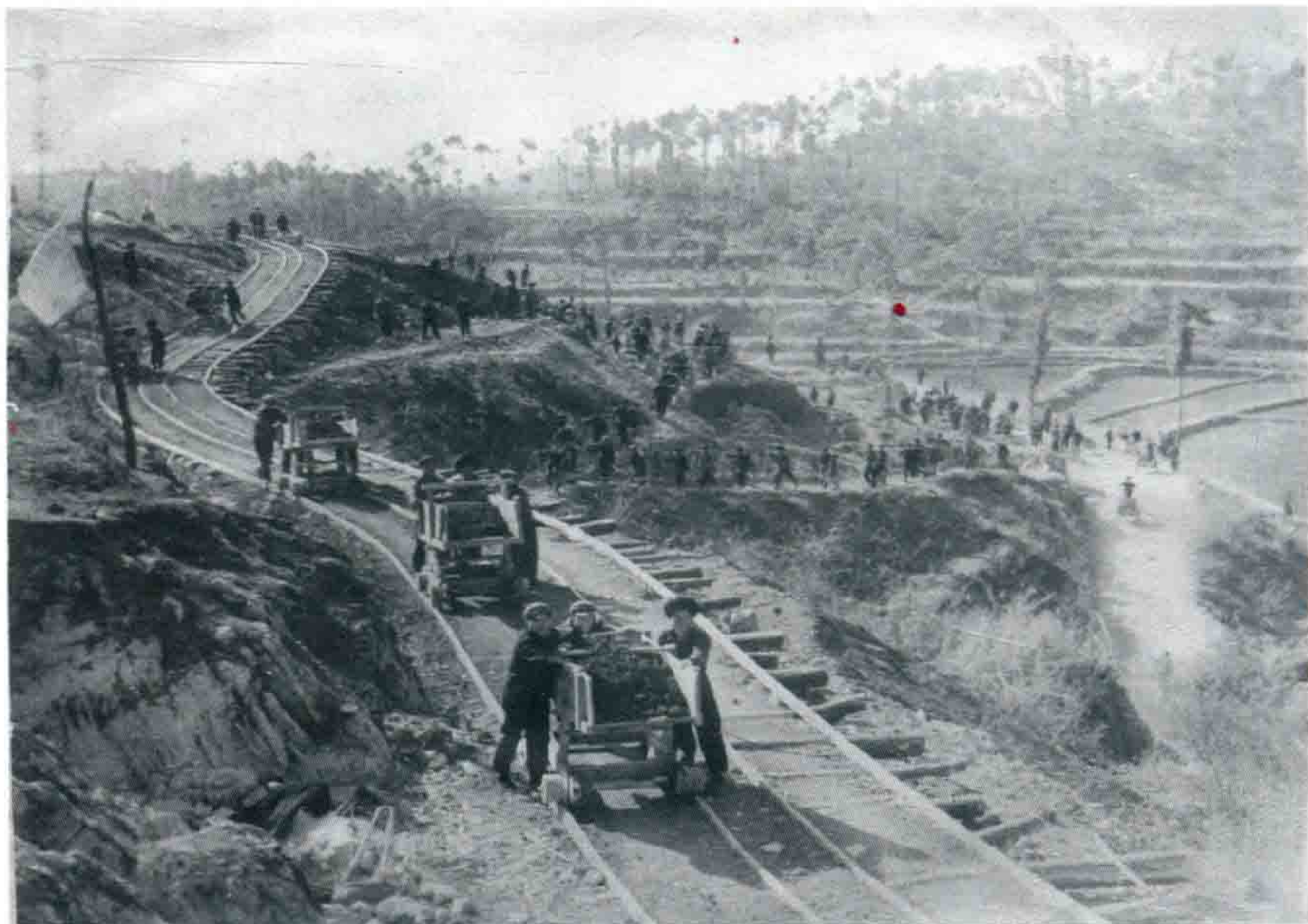
1966年12月，在务沅公社修建架枳水库
